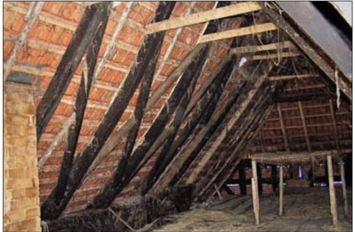
*Blick in das Dach des Renaissance-Gebäudes. Die Felder zwischen den Sparren werden durch überblattete Windrispen (hier Andreaskreuze) gegen Winddruck ausgesteift.*
