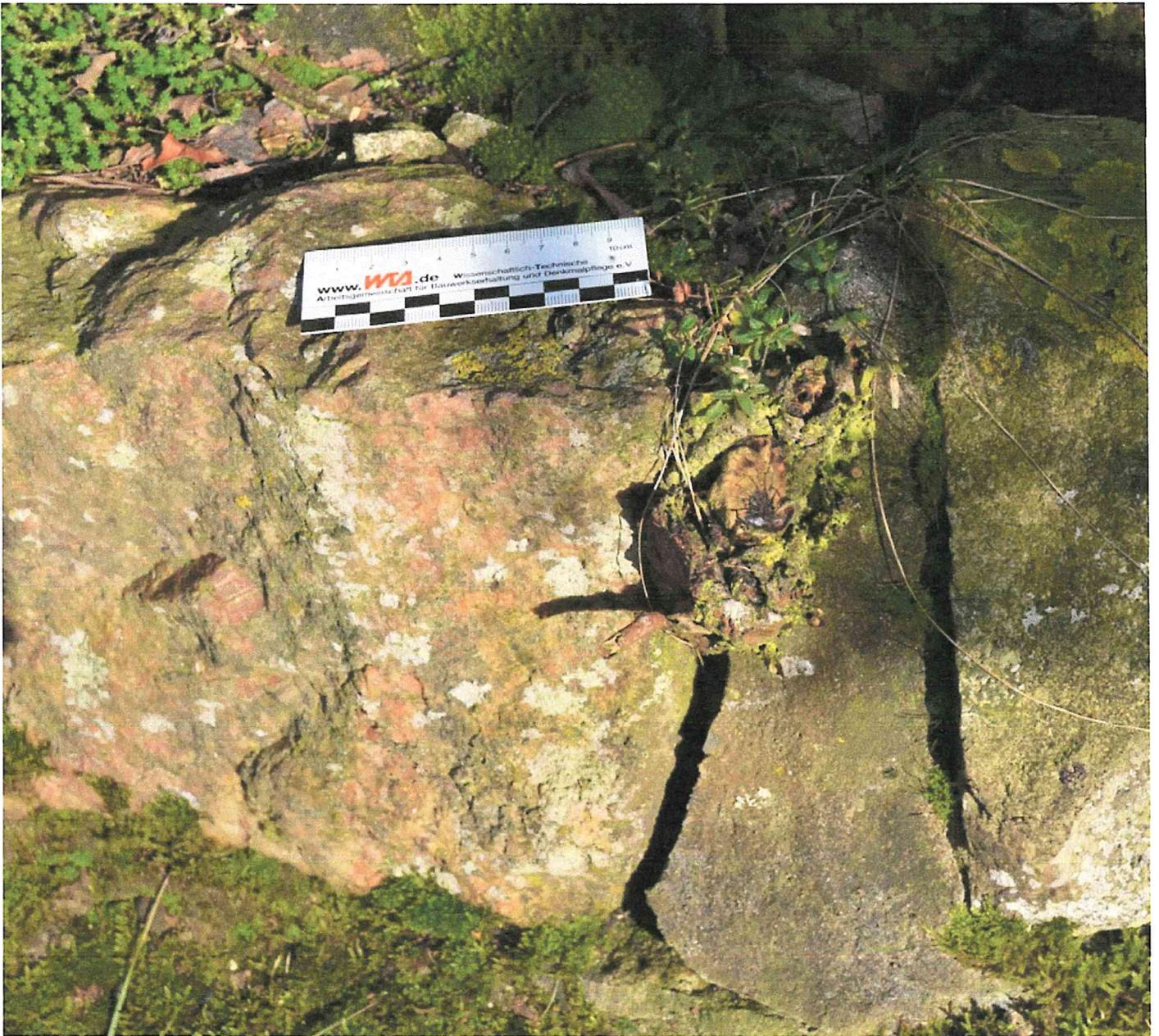
Gerissene Fugen und starker Bewuchs im Mauerwerk. Siehe Pos.1.
